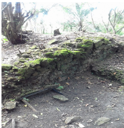
Fotografia 1 – Fundação em pedra da capela do Engenho Jaguaribe. Fonte: Luanderson Ferraz, Agosto de 2017.
