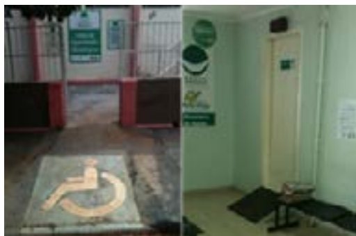
Fotos de ambientes acessíveis em CEO do Estado de Goiás, 2014.
