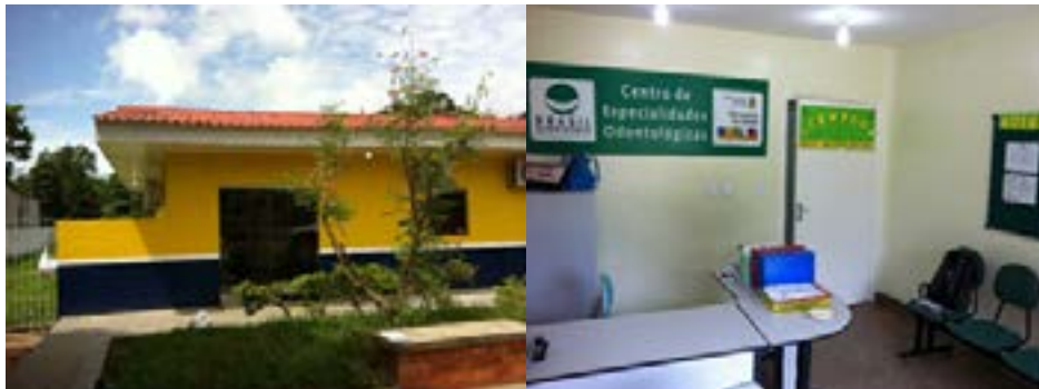
Figura 10 – Fachada; Recepção; Sala de espera.
